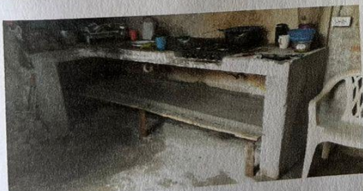
Se fundió entrepañó al mesón de la cocina para facilitar almacenamiento.
