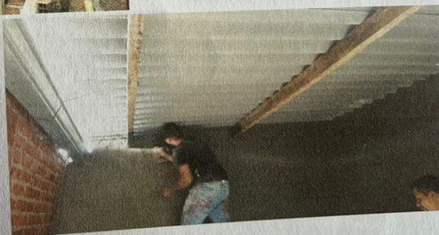
Se fundió columneta adicional, se completó muro y se adecuó un espacio para alcoba ubicada al lado de patio, con su cubierta en eternit.
